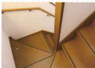
法定基準最小の幅75cm、手すり付きの階段
